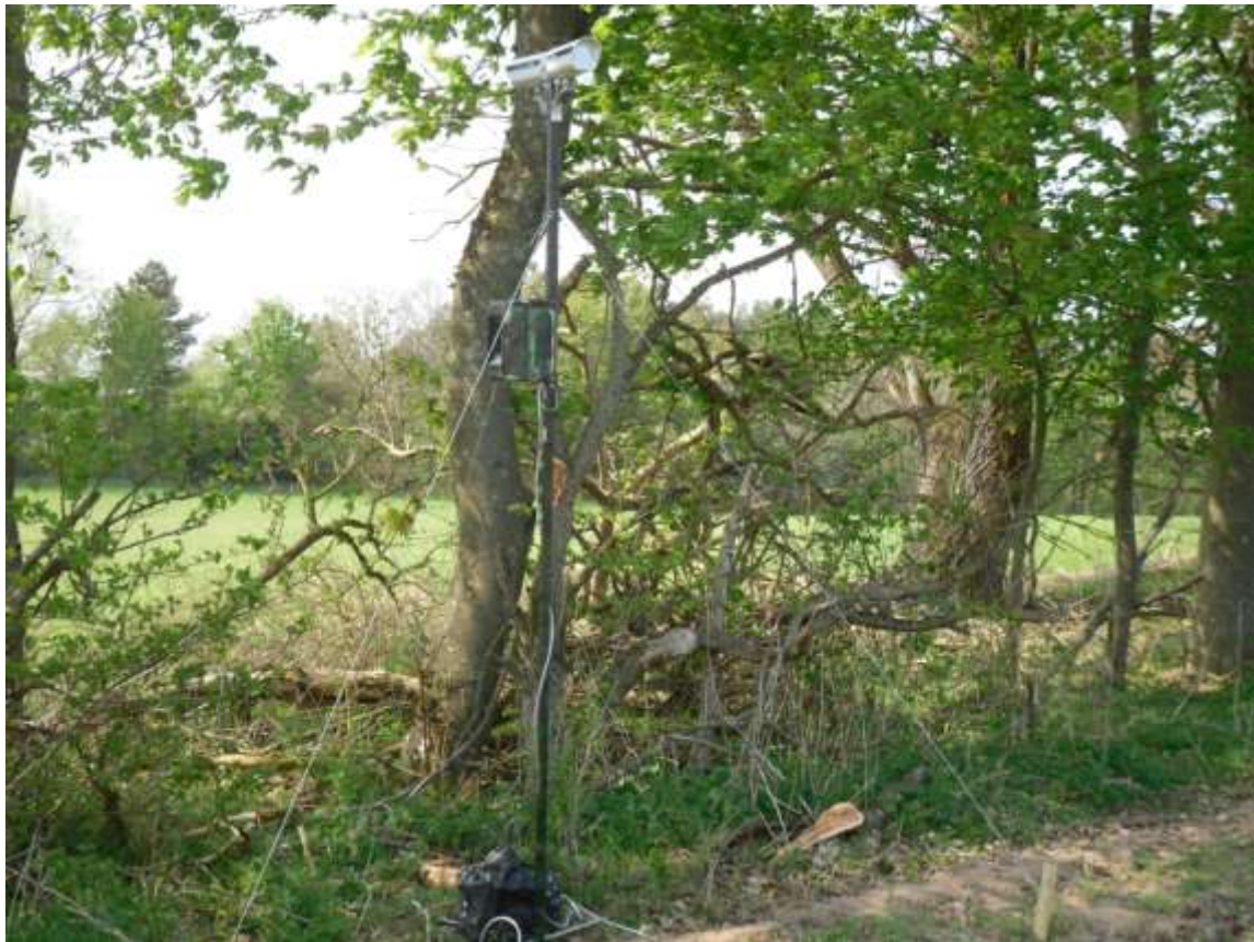
Overvågningsanlæg med to sensorer, controller og batteri.
